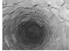
Fig. 14. Vista cenital zona de extracción
